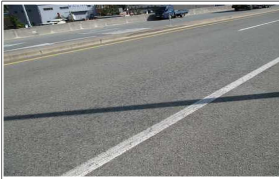
교면포장 군도8호선방향 S3 라벨링
